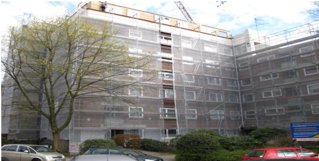
Modernisiert und aufgestockt: Groten Hoff 7 - 19 in Hamburg-Volksdorf
