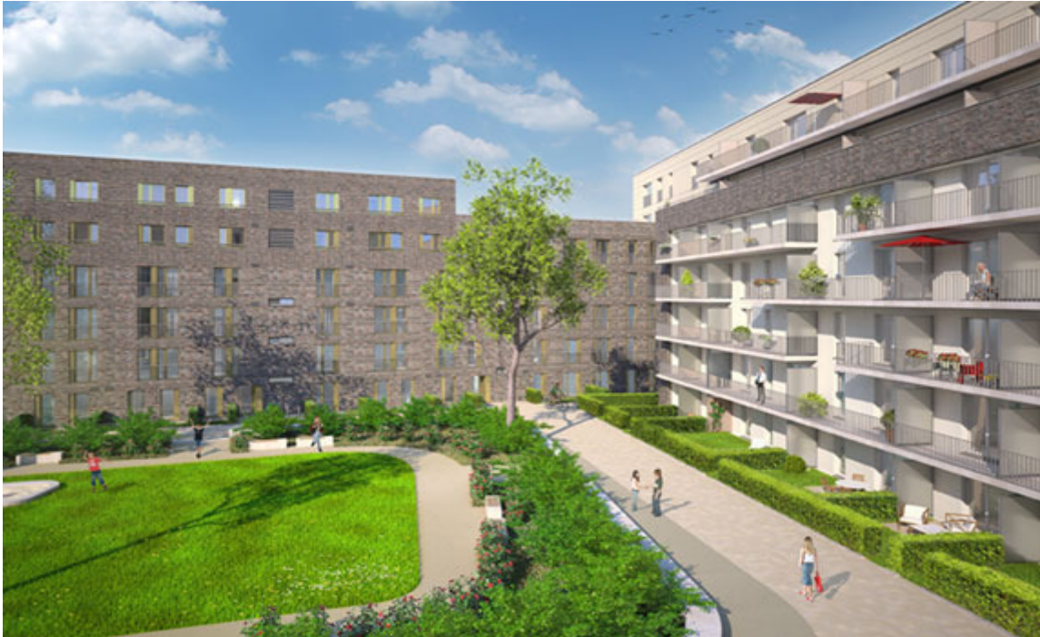
Neubau: Gaußstraße in 22765 Hamburg-Ottensen
